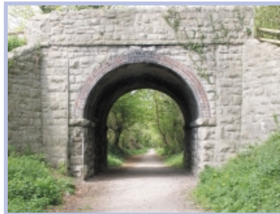
Pont garreg dros Rodfa Dyserth-Prestatyn.
